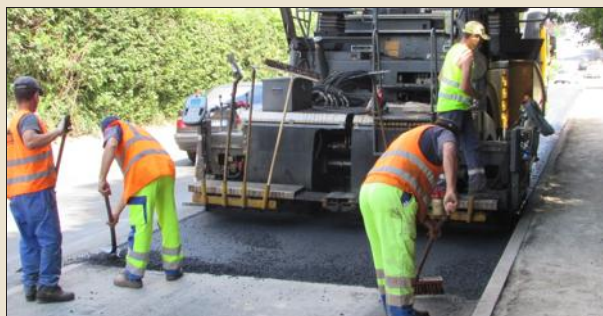
■ Du béton est ajouté sur les bords rabotés. Photo P. MARCHAND
